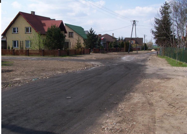
Zdjęcie nr 6 – odtworzenie nawierzchni dróg po wykonaniu inwestycji – ulica Barbary w Kłodawie.
