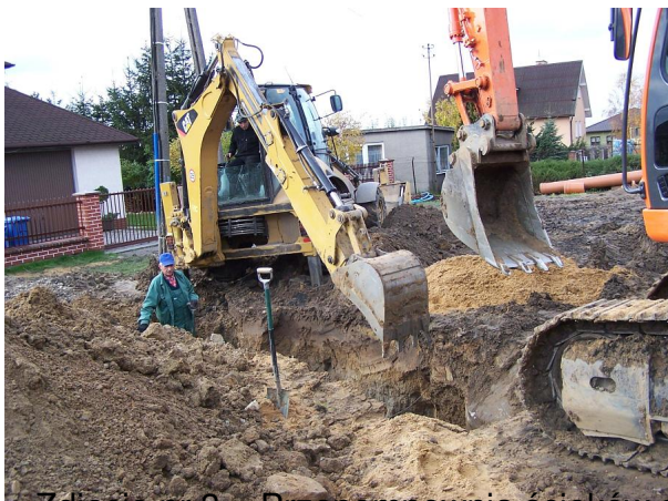
Zdjęcie nr 3 – Przenośna sieć sanitarnych przy ulicy Zawodniej w Kłodawie.
