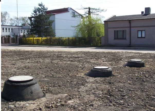
Zdjęcie nr 5 – odtworzenie nawierzchni dróg po wykonaniu inwestycji – ulica Gruntowa w Kłodawie.
